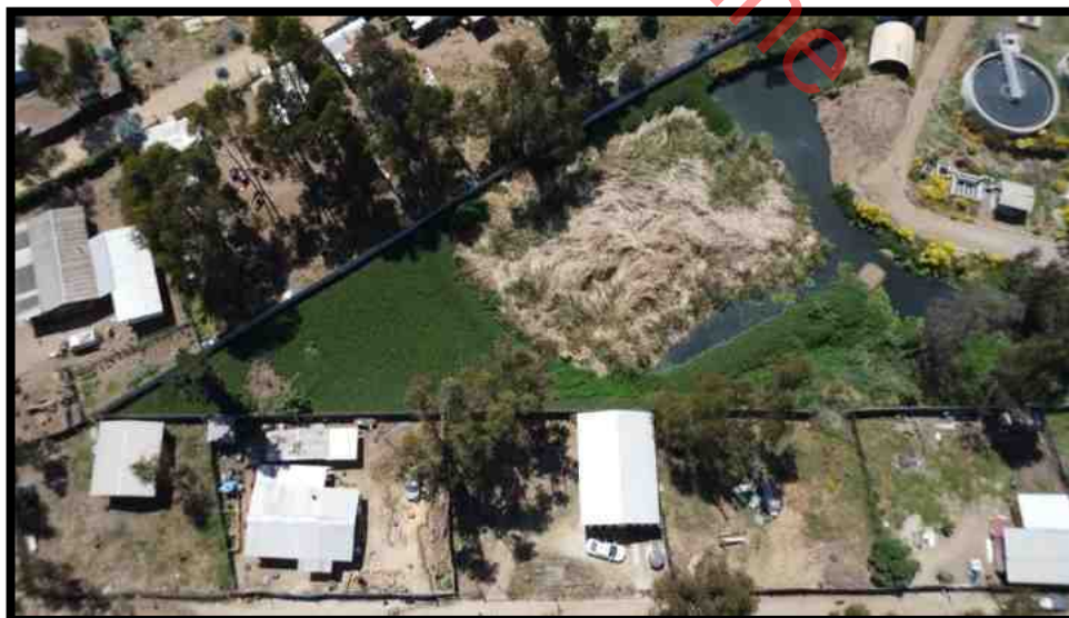
Foto N° 2 – Vista aérea zanja drenes
